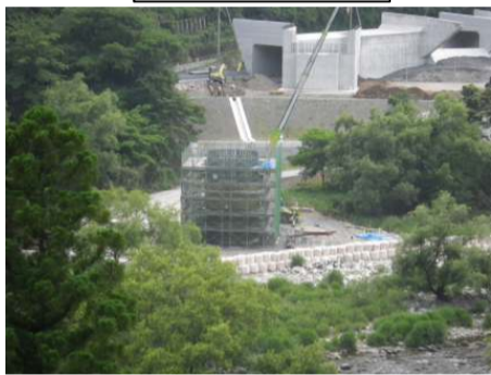
左岸側から見た現
