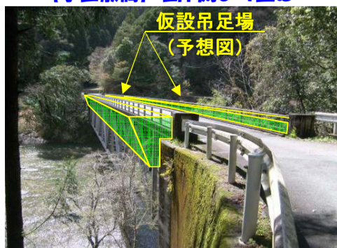
【小田敷橋】左岸側より望む
