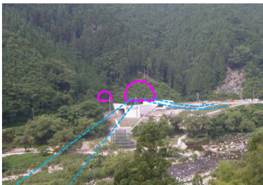
対岸からトンネル坑口を撮影
