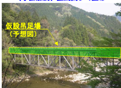
【小田敷橋】上流側より望む
