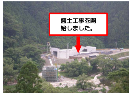
現場全景 大千瀬川対岸より撮影
