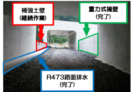
ボックスカルバート内部の様子
