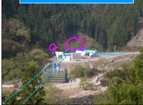
対岸からトンネル坑口を撮影
