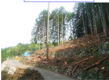
市道小田敷線内の様子
