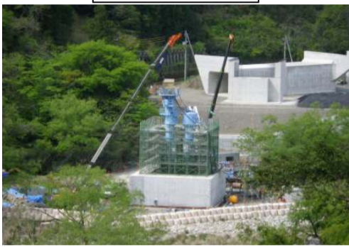
左岸側から見た現
