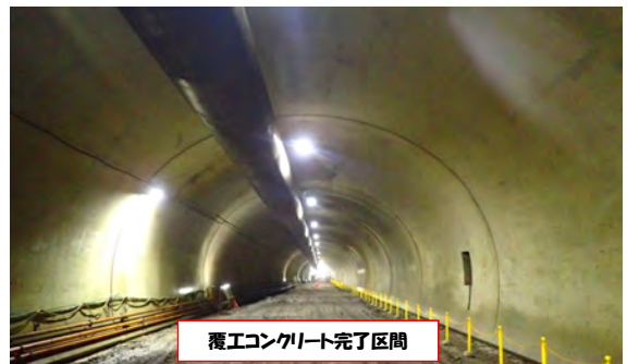
工事箇所全景
