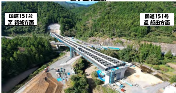
工事箇所全景
