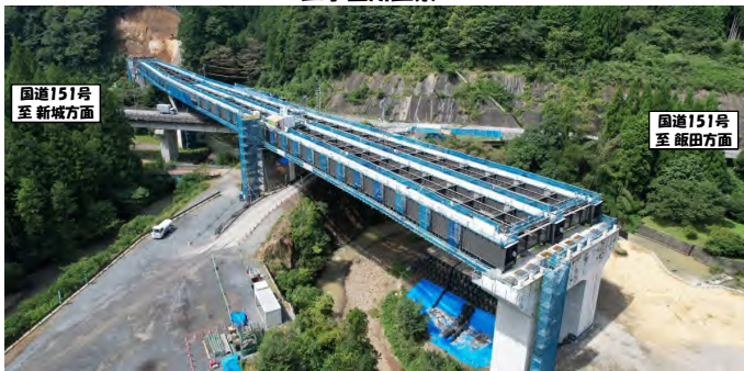
工事箇所全景
