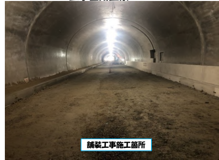
工事箇所全景
