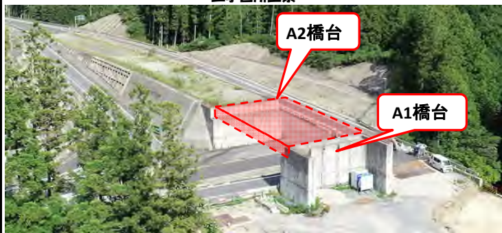
工事箇所全景
