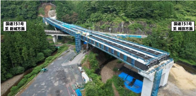
工事箇所全景
