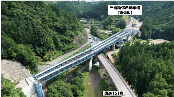
工事箇所全景
