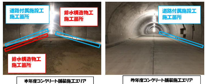
工事箇所全景
