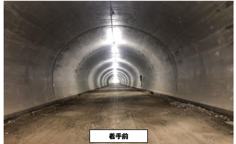
工事箇所全景
