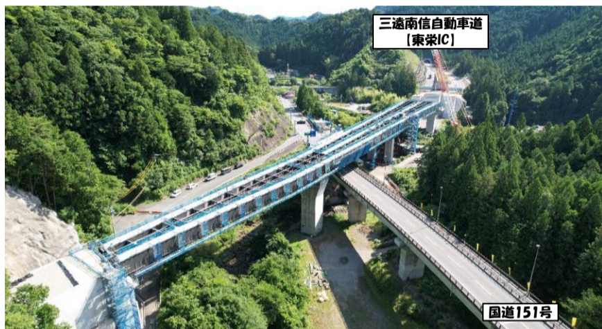
工事箇所全景
