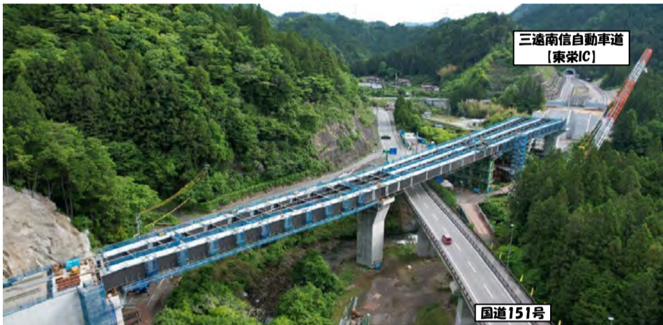
工事箇所全景
