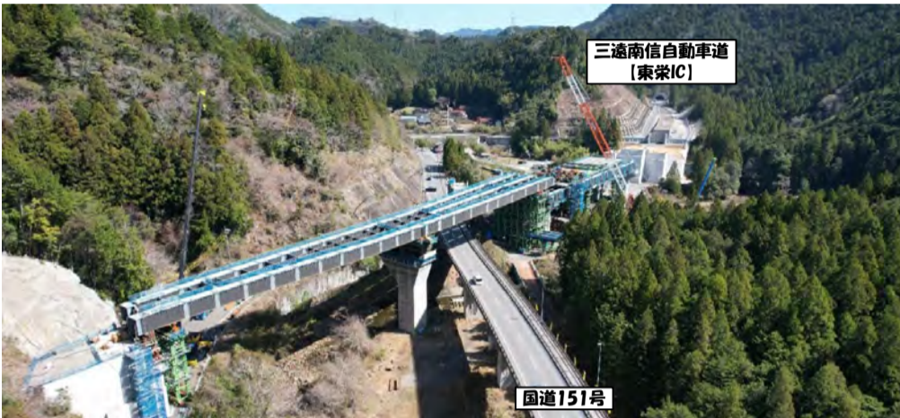
工事箇所全景
