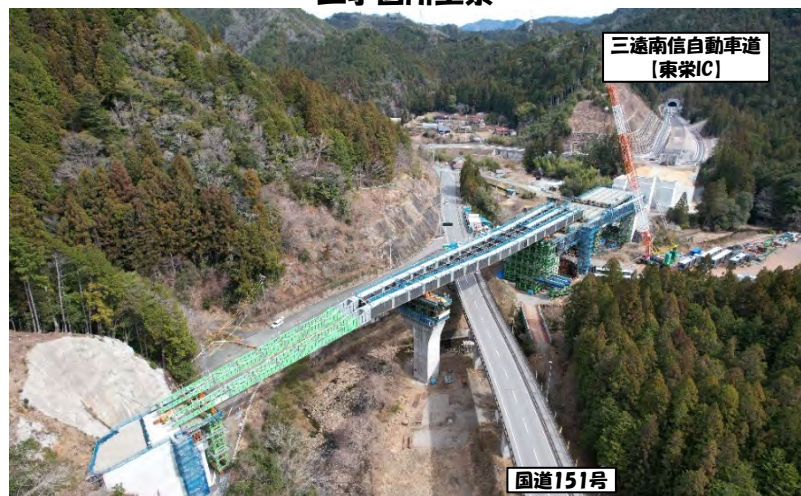
工事箇所全景
