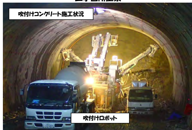
工事箇所全景
