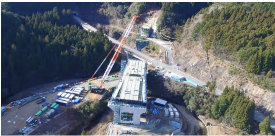
工事箇所全景
