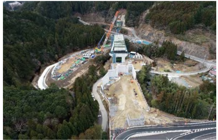
工事箇所全景
