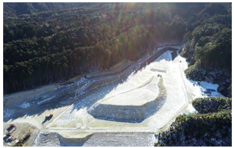
工事箇所全景
