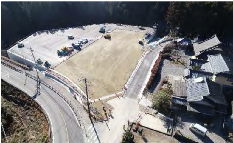
工事箇所全景
