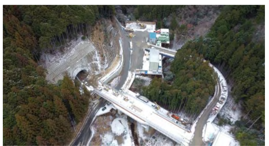
工事箇所全景
