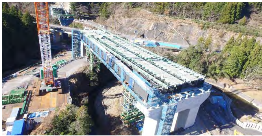
工事箇所全景
