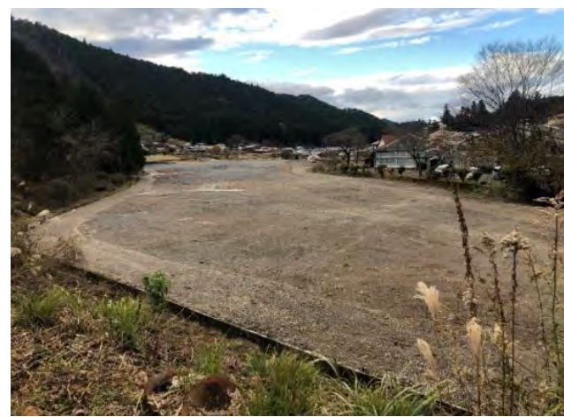
工事箇所全景
