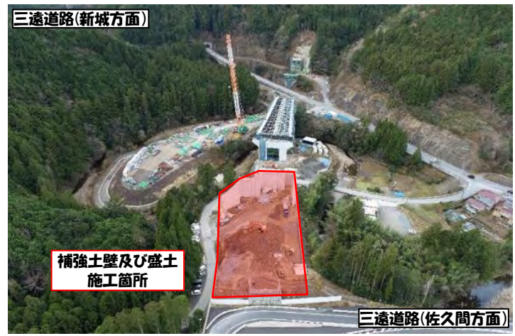
工事箇所全景
