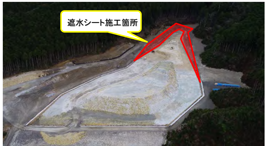
工事箇所全景
