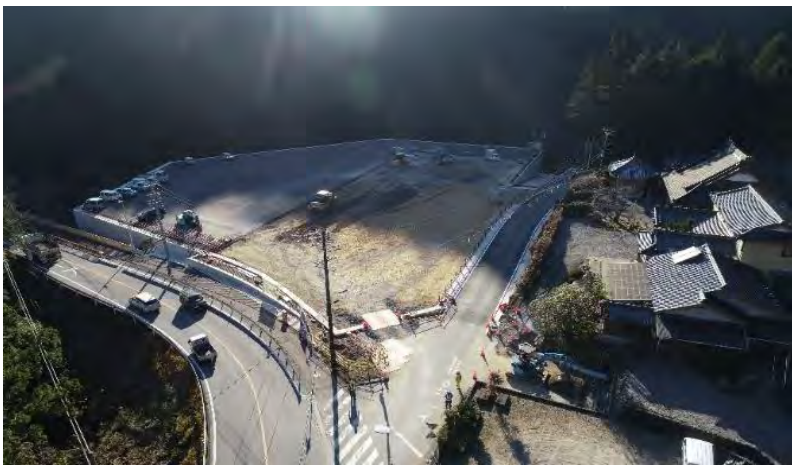
工事箇所全景
