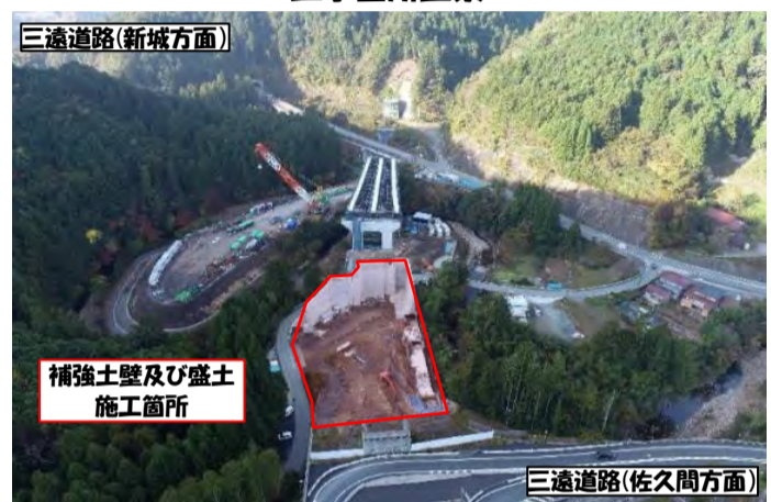
工事箇所全景
