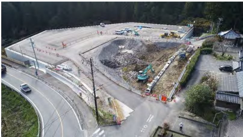
工事箇所全景
