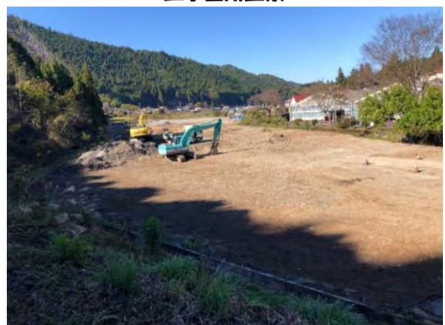
工事箇所全景
