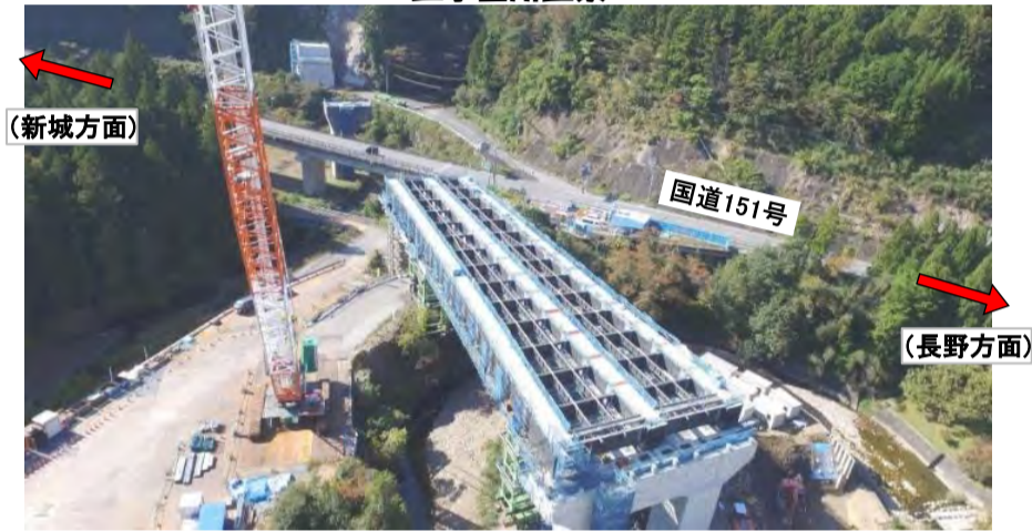
工事箇所全景
