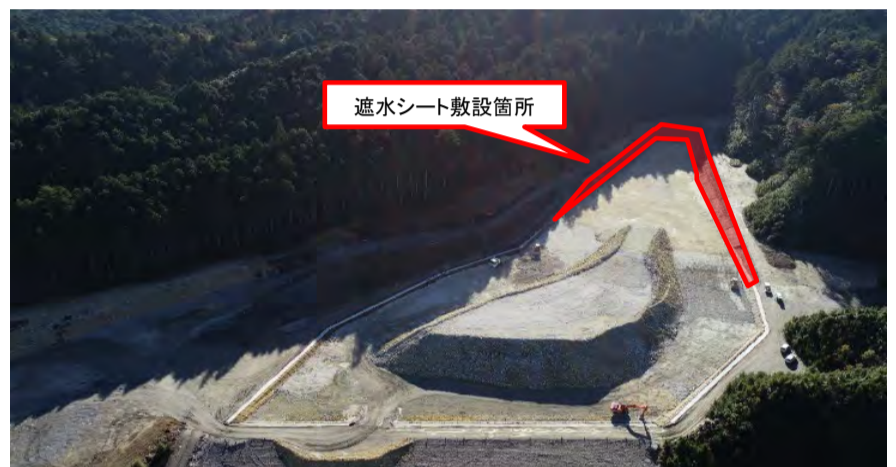
工事箇所全景
