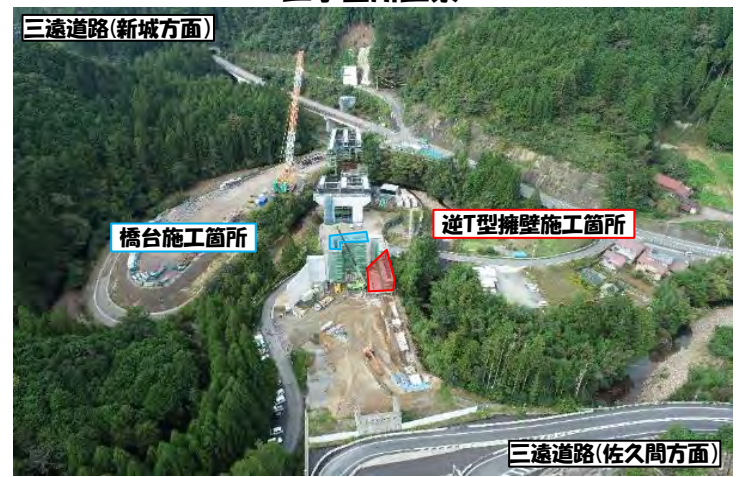
工事箇所全景
