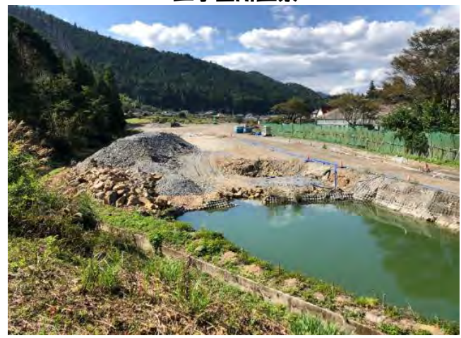
工事箇所全景
