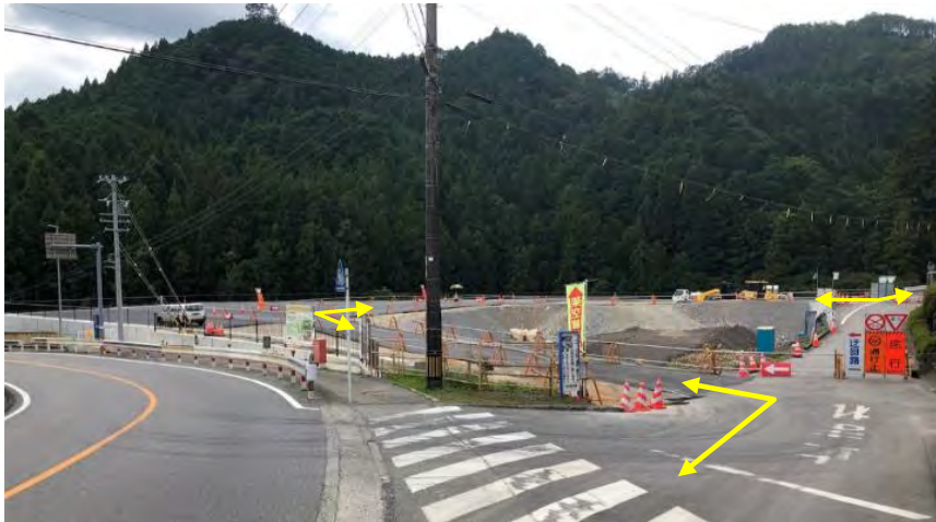
工事箇所全景
