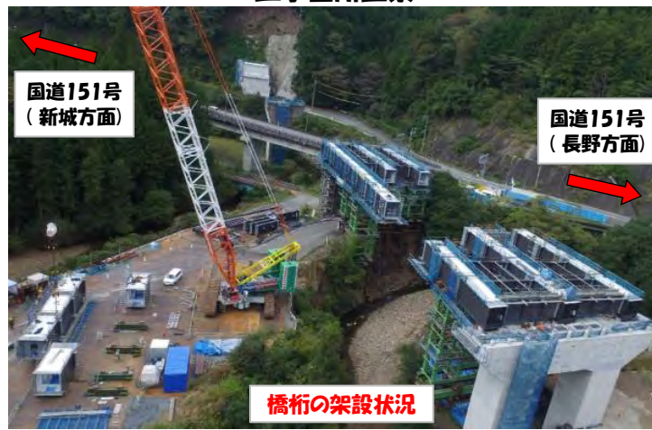
工事箇所全景
