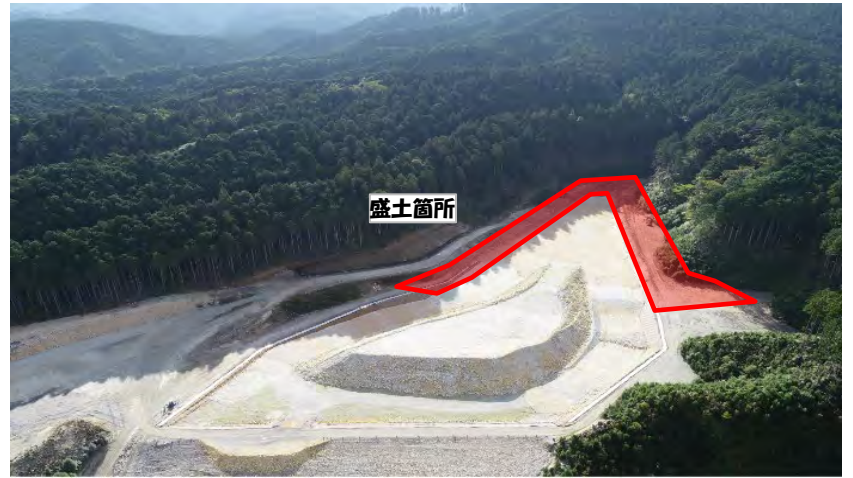
工事箇所全景
