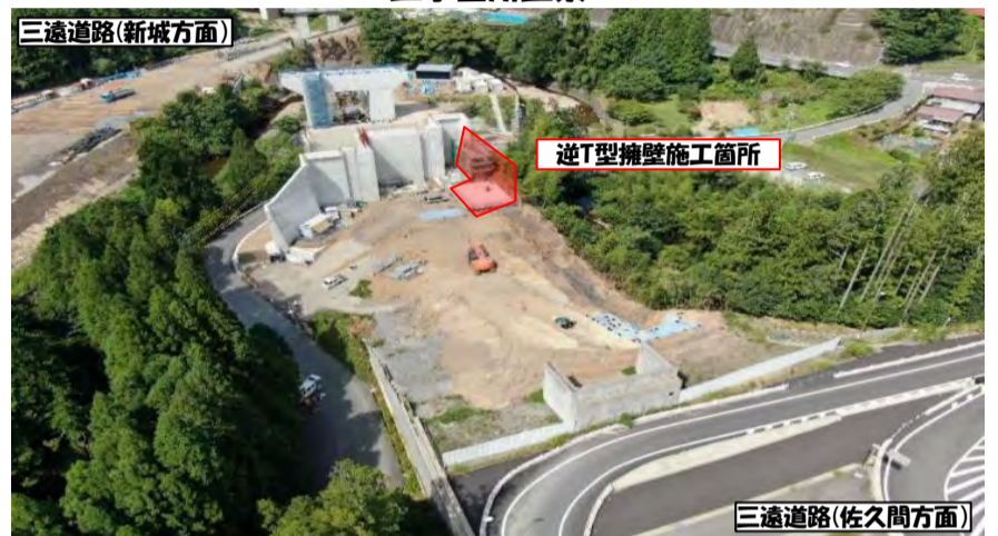
工事箇所全景
