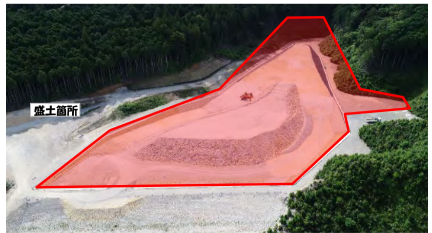
工事箇所全景
