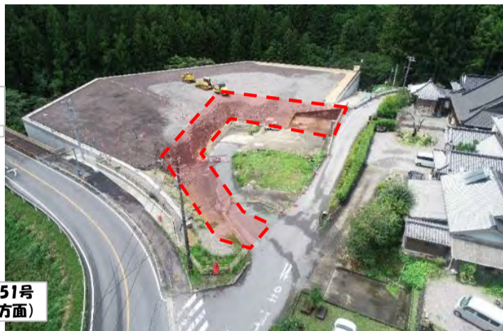
工事箇所全景
