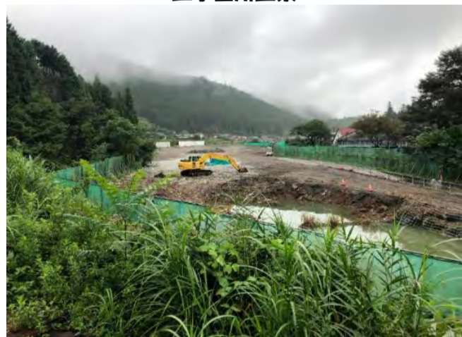
工事箇所全景
