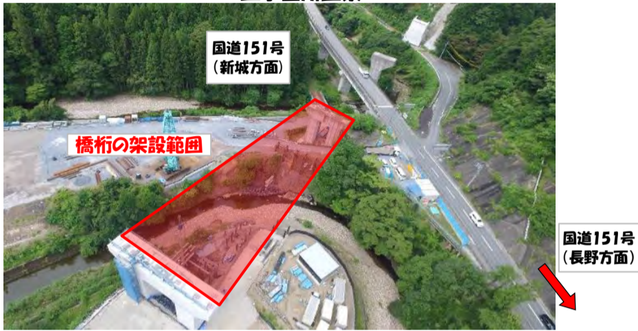
工事箇所全景
