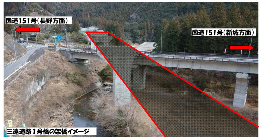
工事箇所全景
