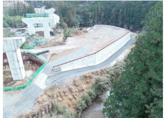
工事箇所全景
