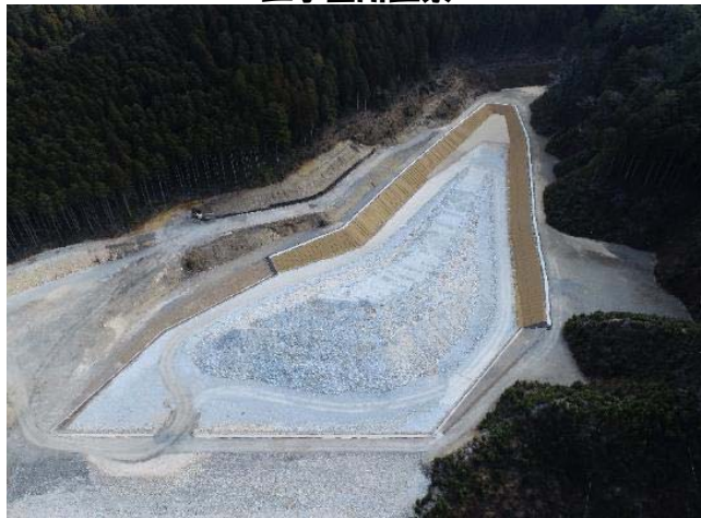
工事箇所全景
