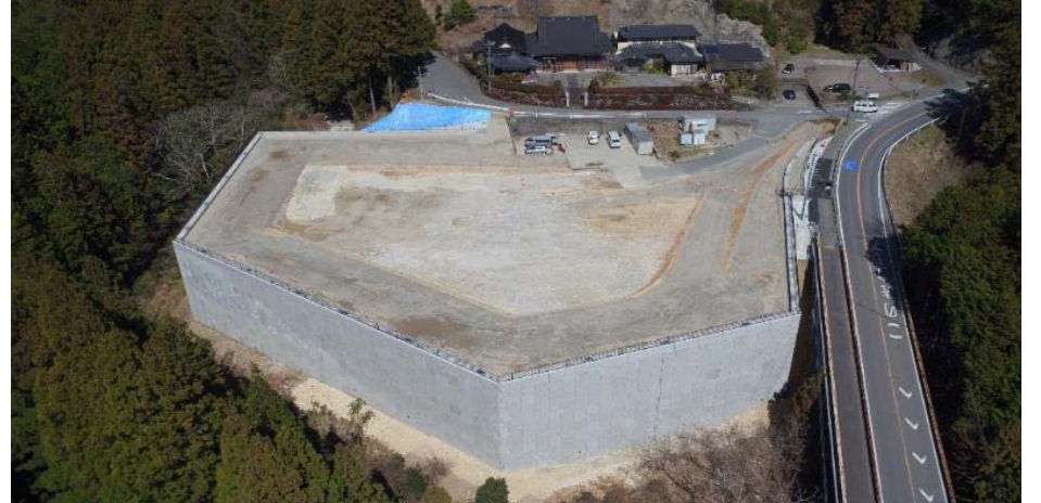
工事箇所全景
