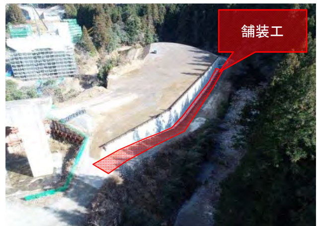
工事箇所全景
