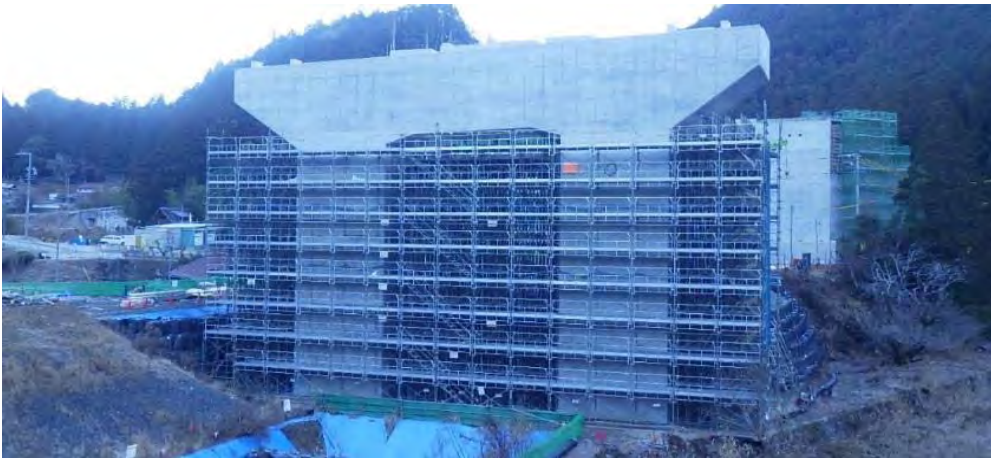
工事箇所全景
