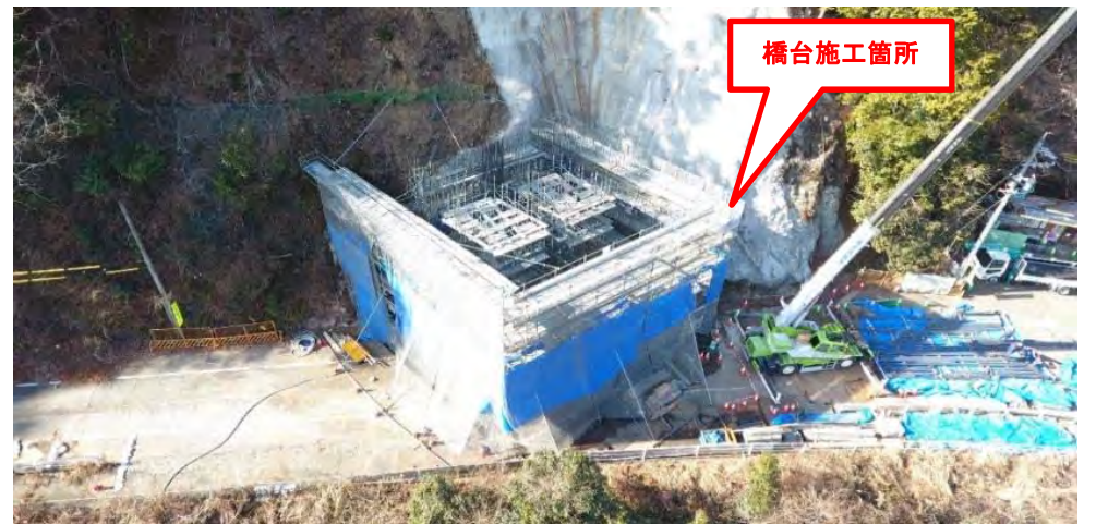
工事箇所全景
