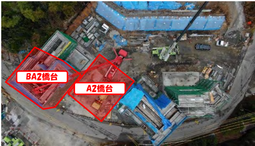
工事箇所全景
