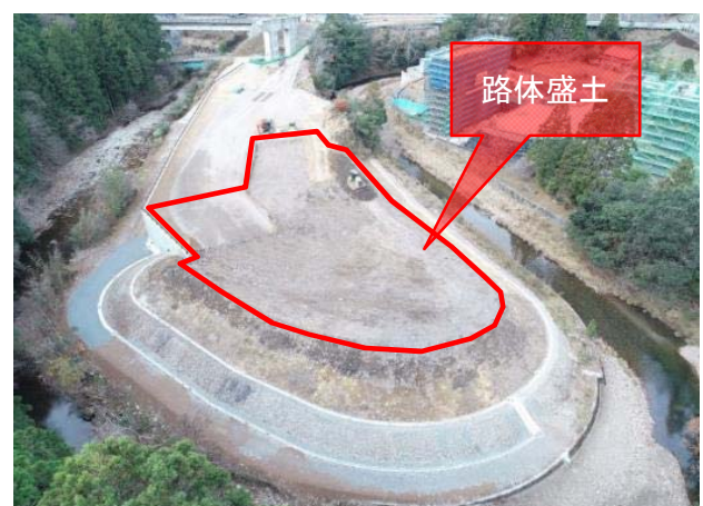
工事箇所全景
