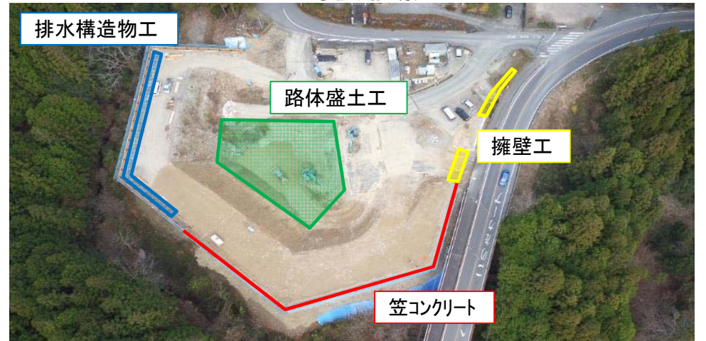
工事箇所全景
