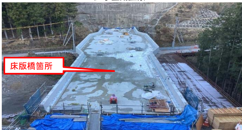
工事箇所全景
