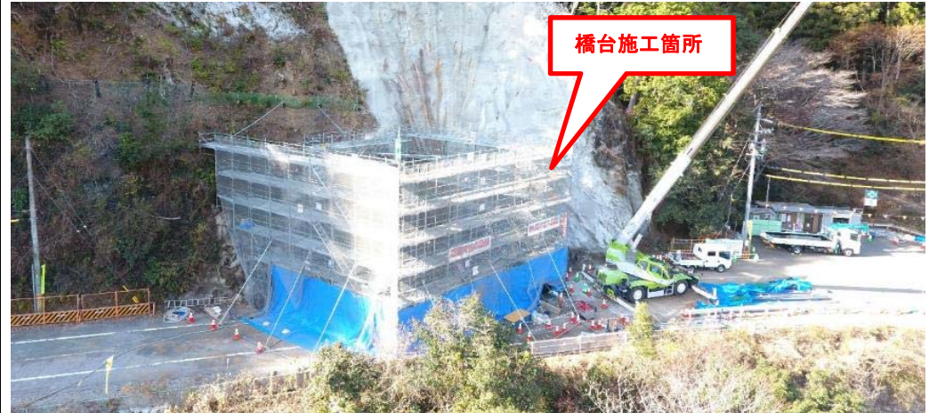
工事箇所全景
