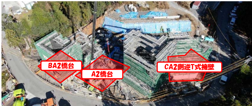
工事箇所全景
