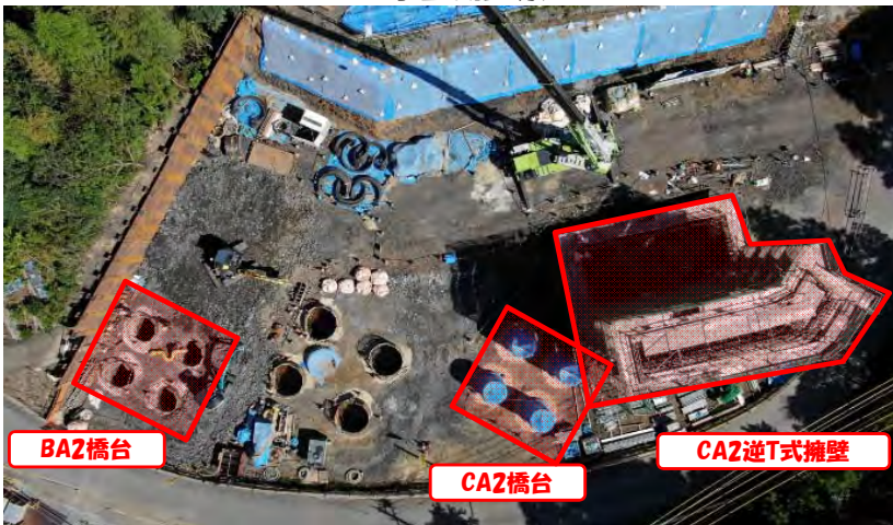
工事箇所全景
