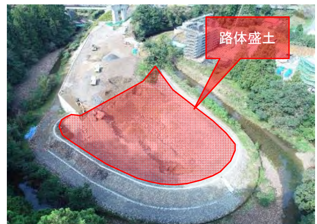
工事箇所全景
