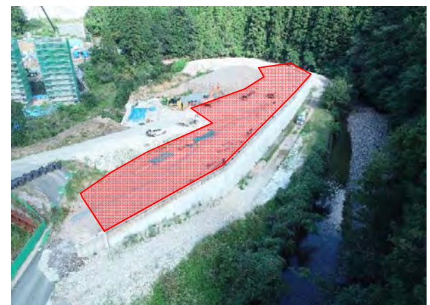
工事箇所全景
