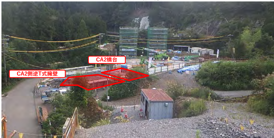
工事箇所全景
