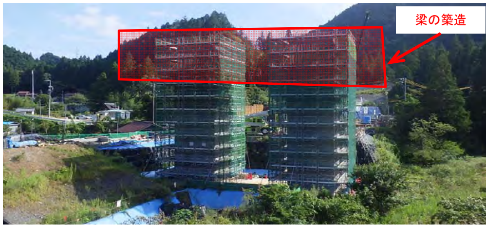
工事箇所全景
