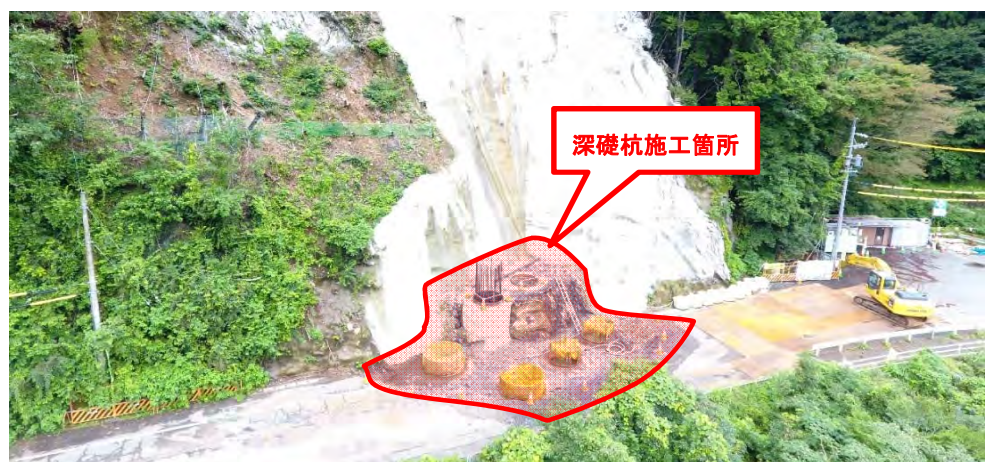
工事箇所全景
