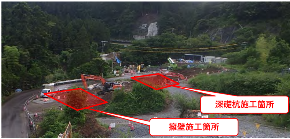
工事箇所全景
