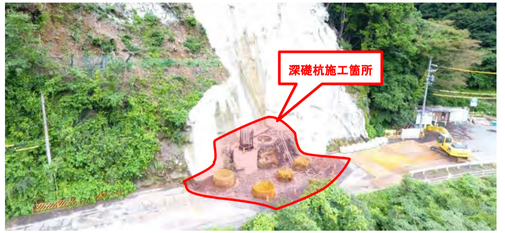
工事箇所全景
