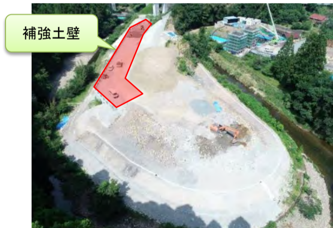
工事箇所全景
