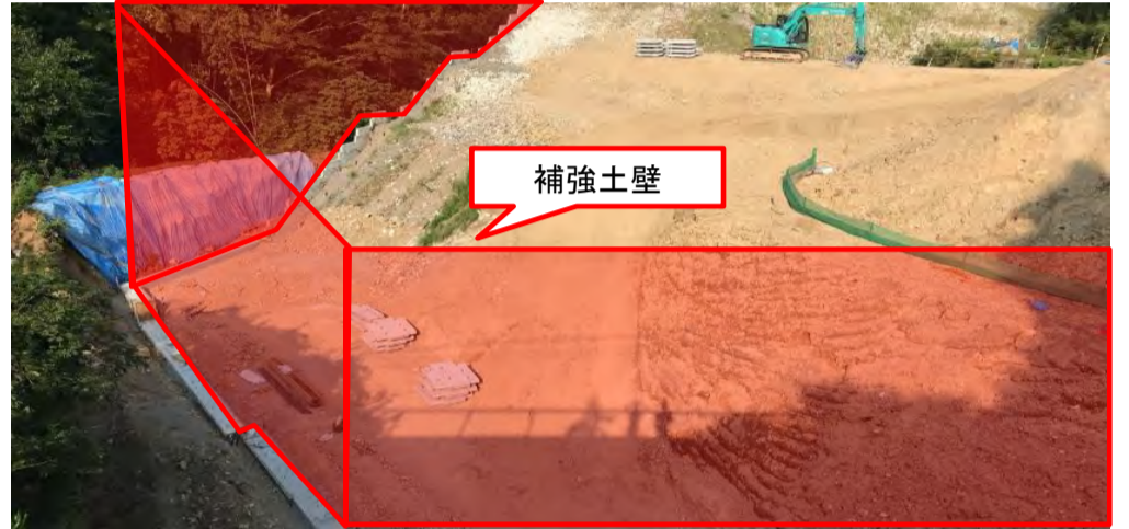
工事箇所全景
