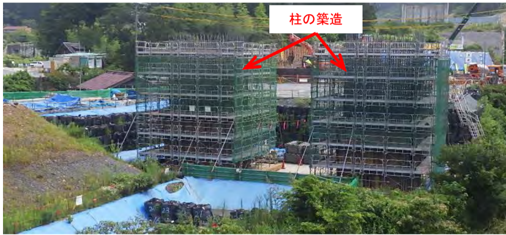
工事箇所全景
