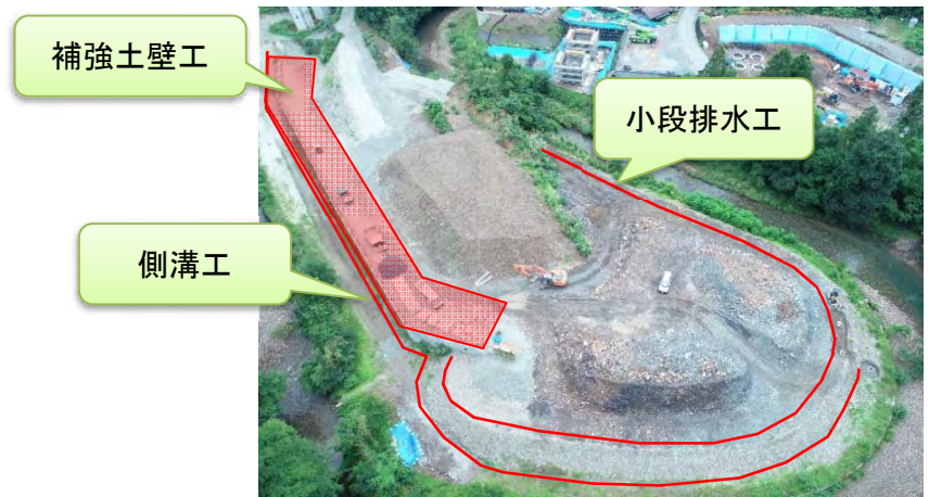
工事箇所全景
