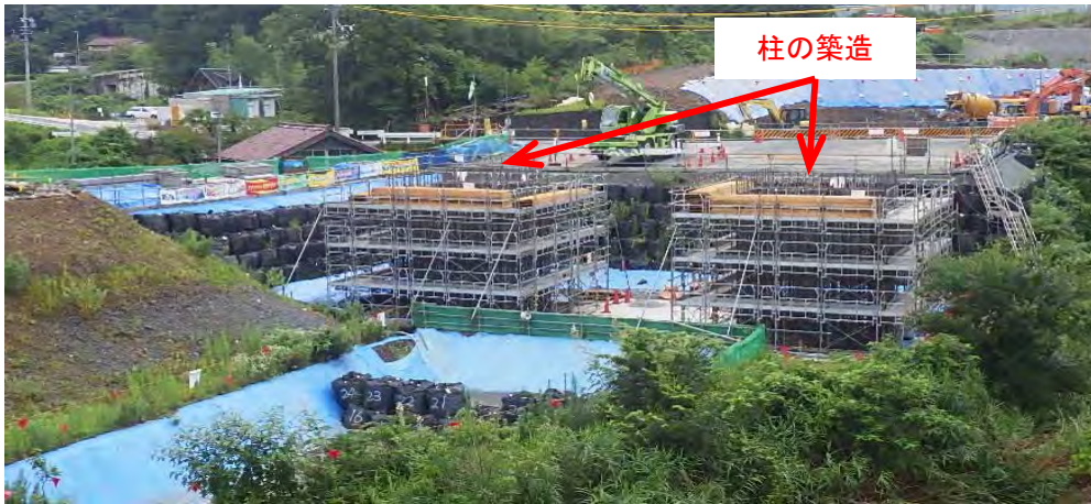
工事箇所全景
