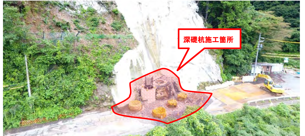
工事箇所全景
