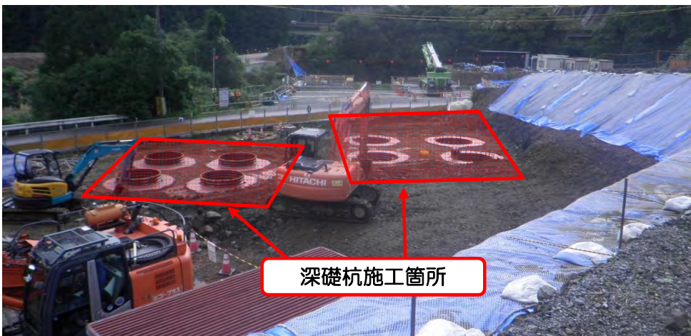
工事箇所全景
