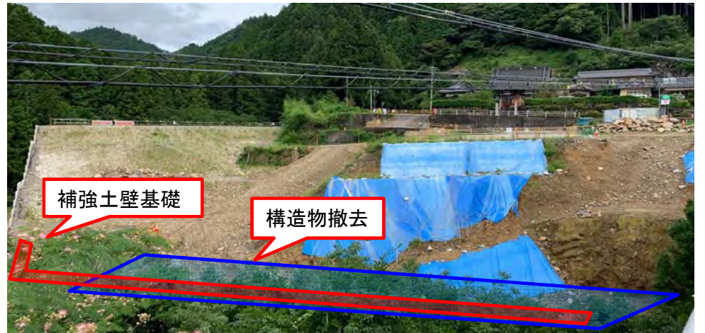
工事箇所全景
