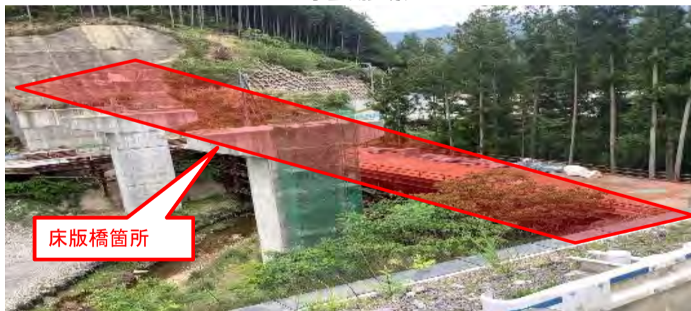
工事箇所全景
