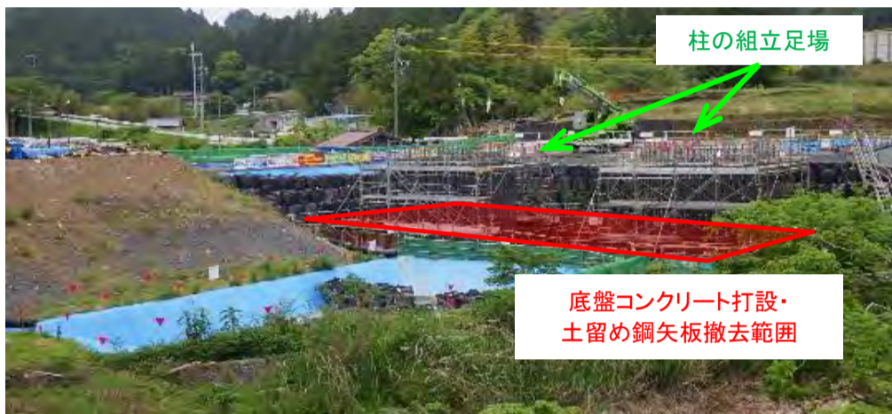
工事箇所全景
