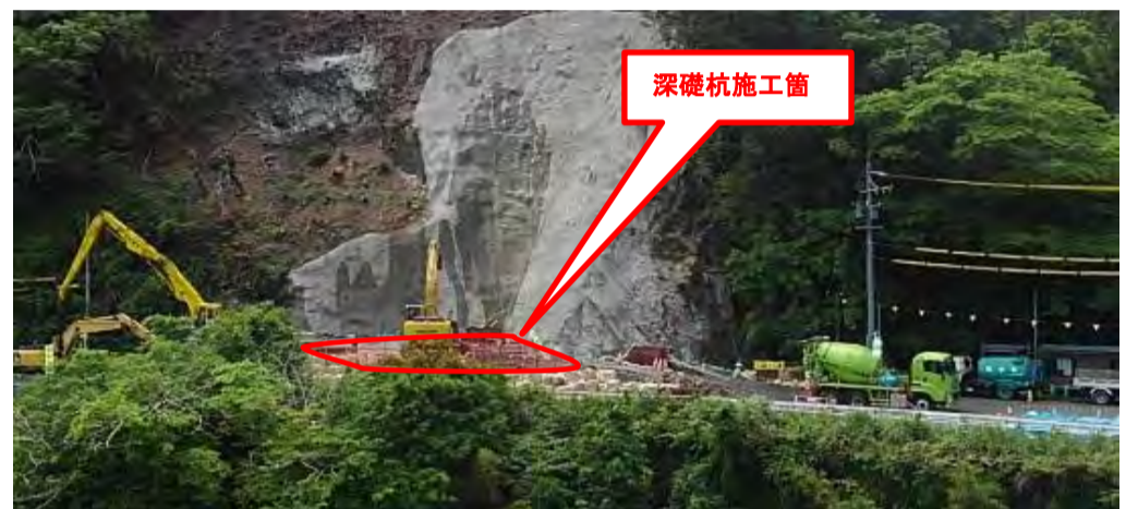
工事箇所全景
