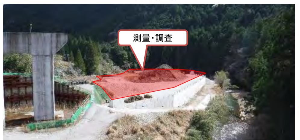
工事箇所全景
