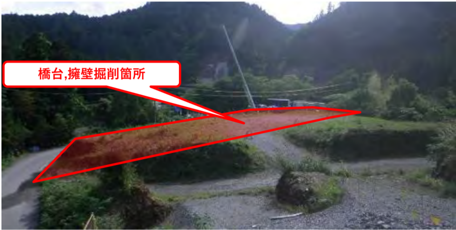
工事箇所全景
