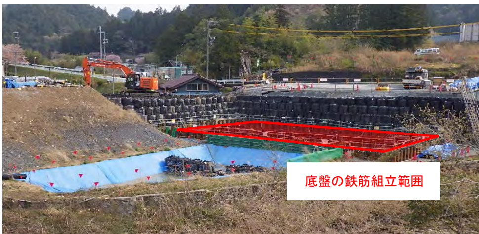
工事箇所全景
