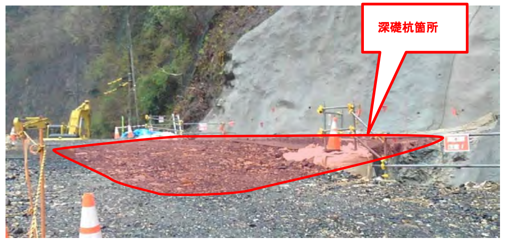
工事箇所全景
