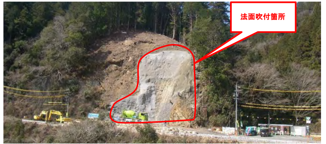
工事箇所全景
