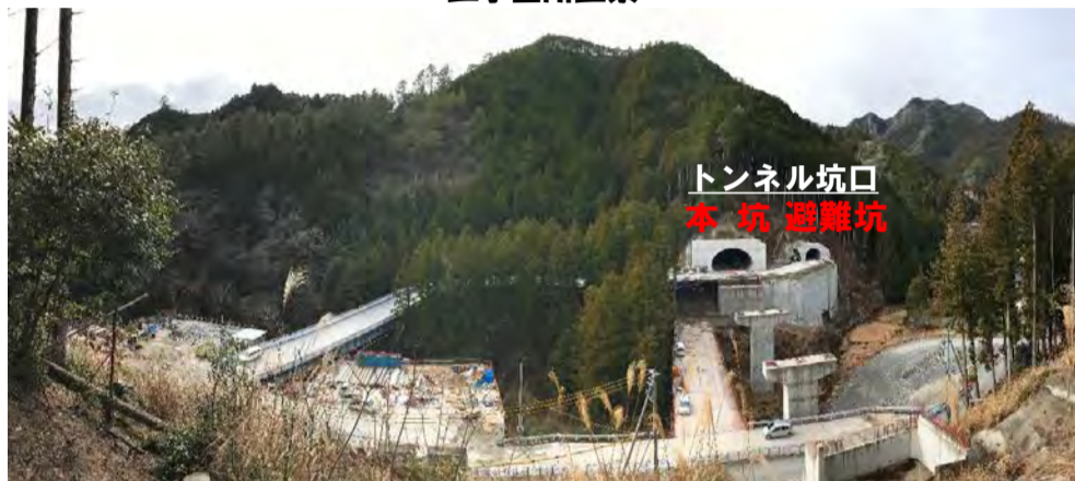
工事箇所全景
