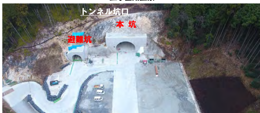
工事箇所全景
