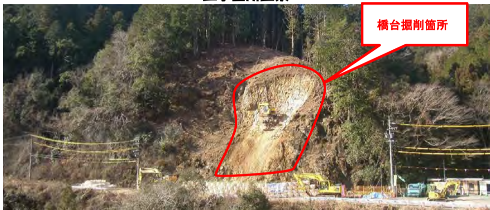
工事箇所全景
