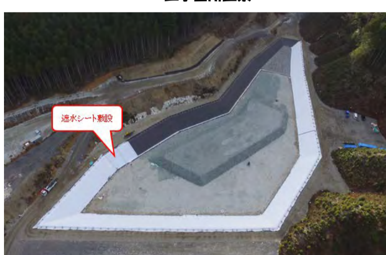
工事箇所全景
