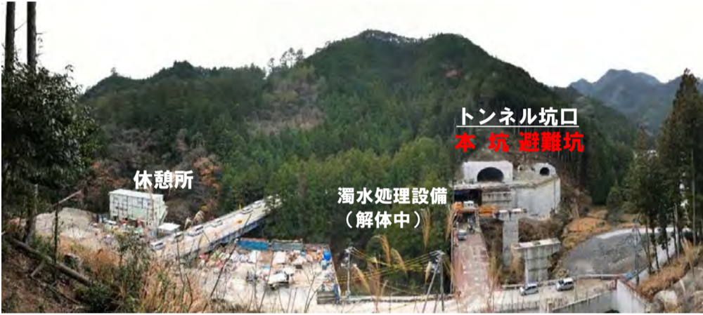
工事箇所全景
