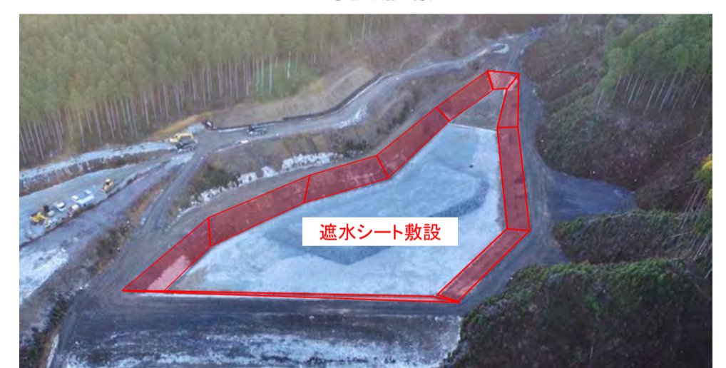
工事箇所全景
