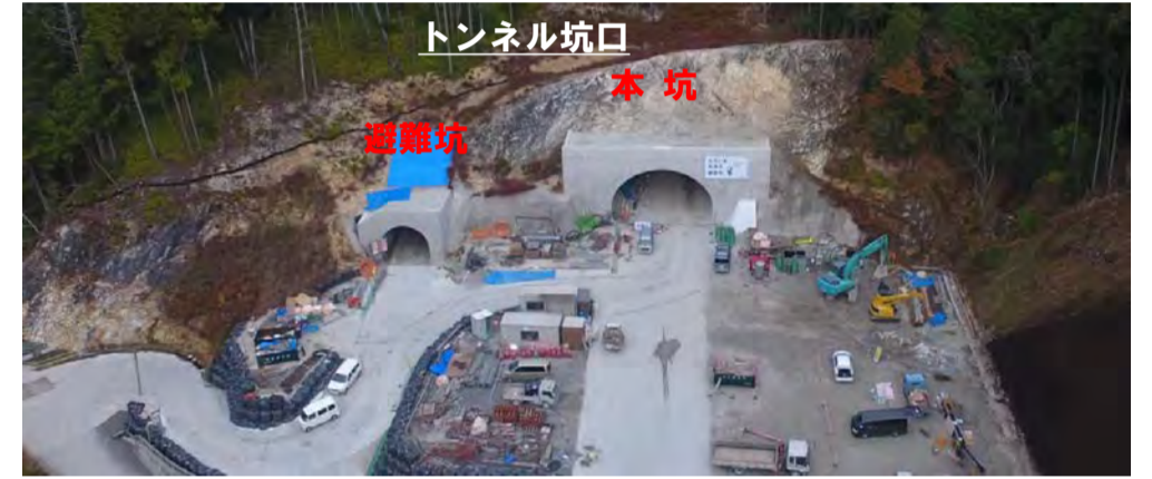
工事箇所全景
