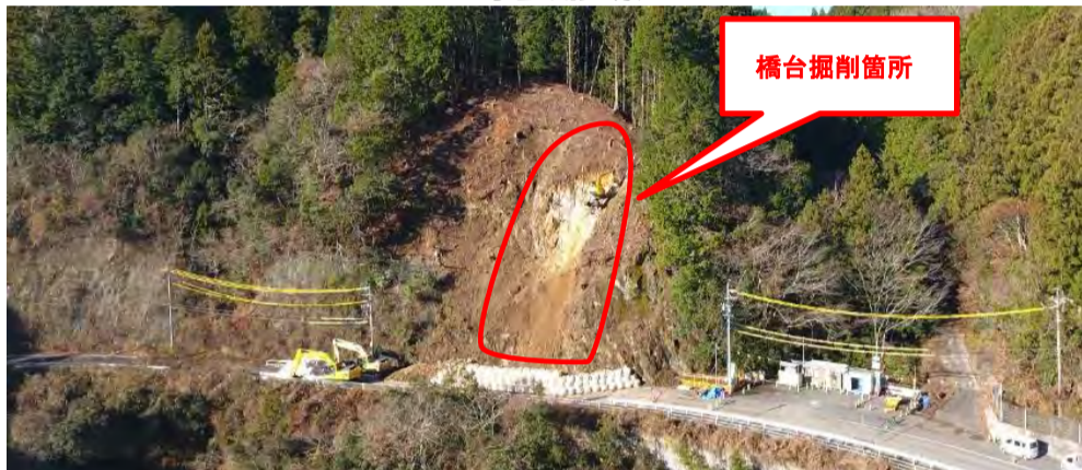
工事箇所全景
