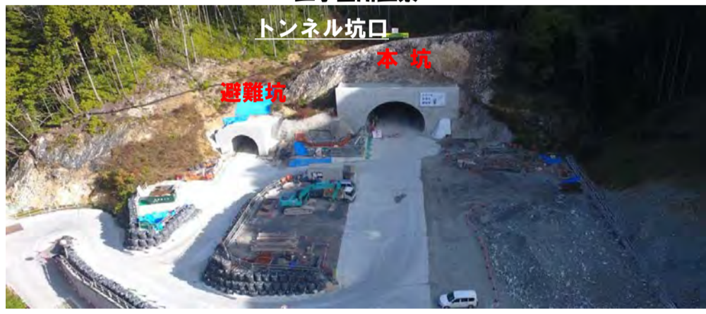
工事箇所全景
