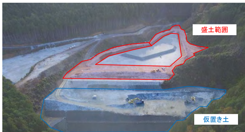
工事箇所全景
