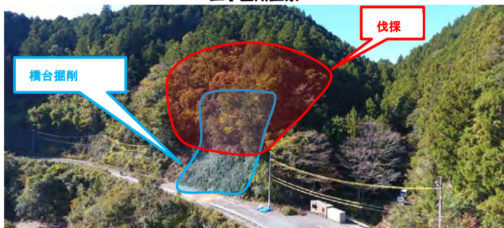
工事箇所全景
