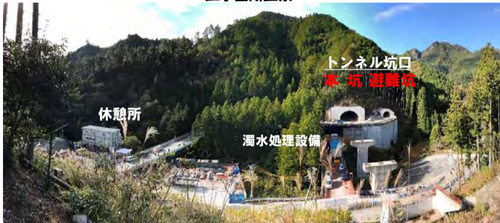
工事箇所全景
