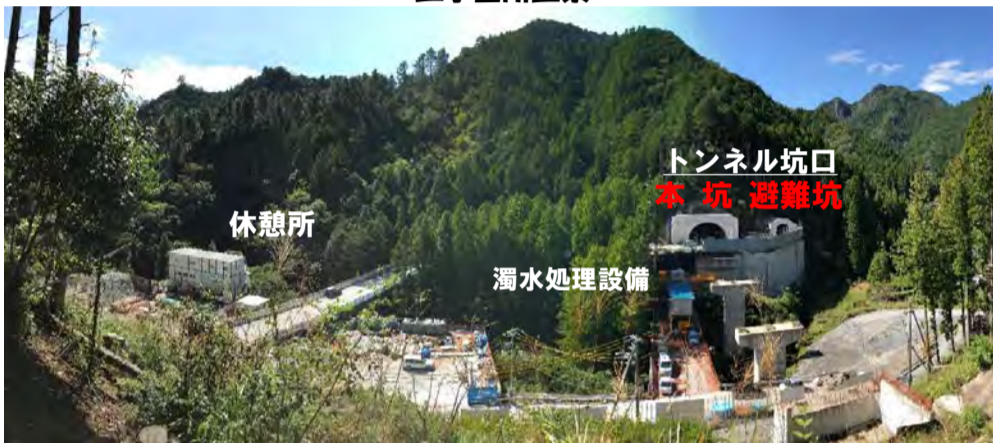
工事箇所全景
