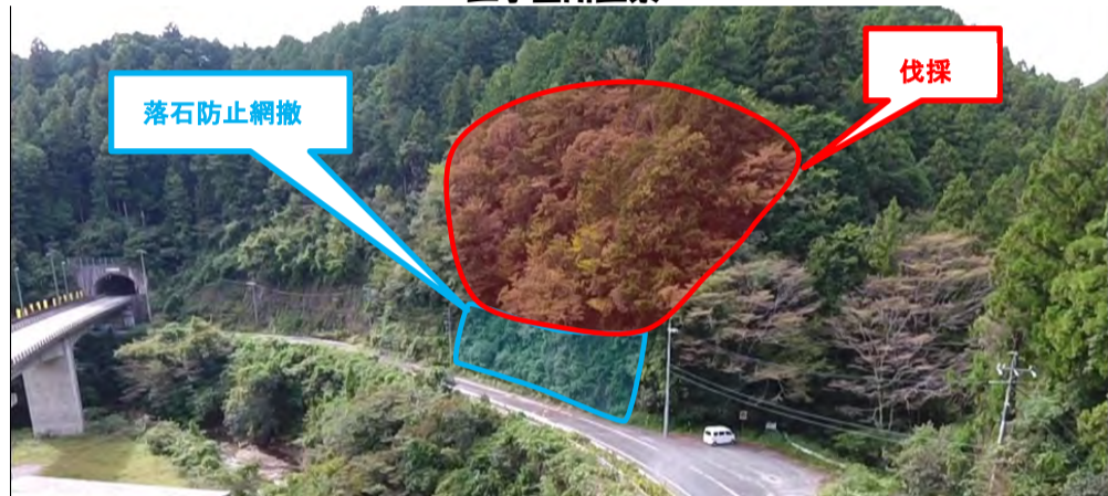
工事箇所全景
