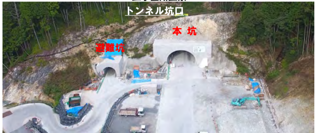
工事箇所全景
