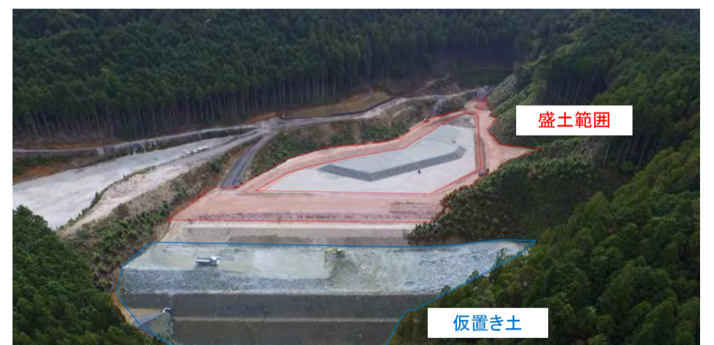
工事箇所全景
