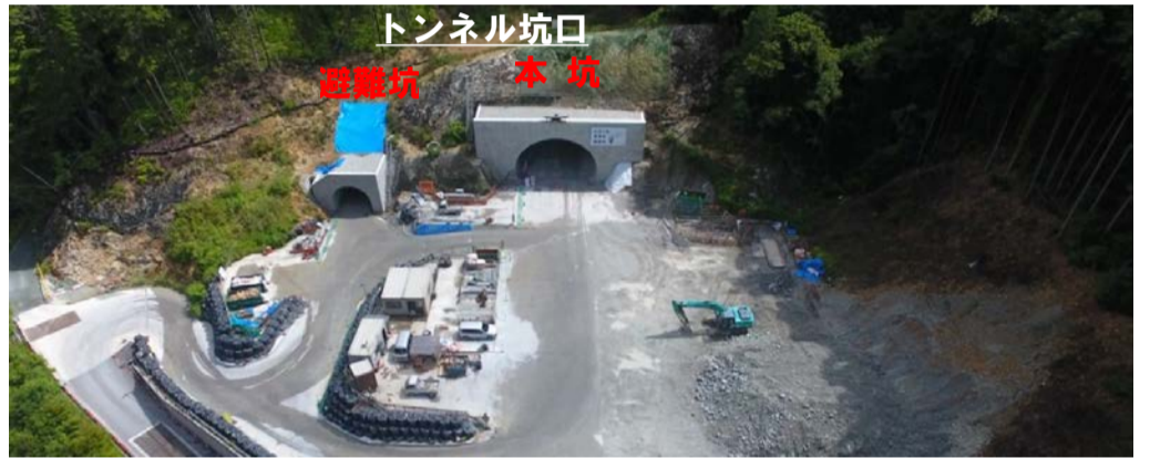
工事箇所全景
