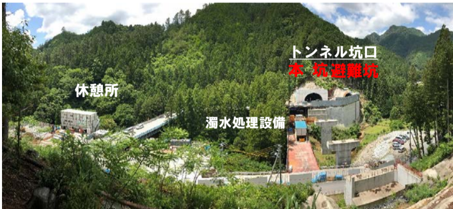
工事箇所全景
