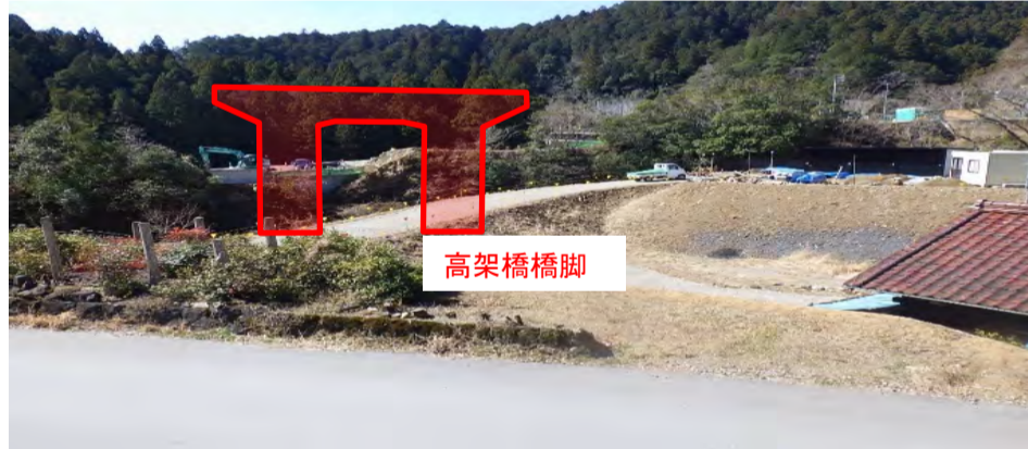
工事箇所全景
