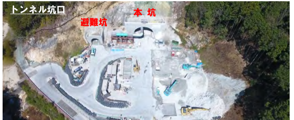
工事箇所全景
