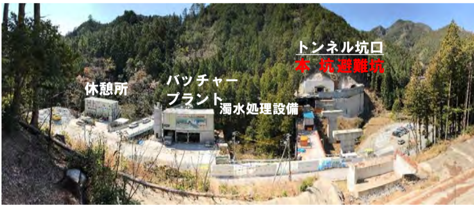
工事箇所全景
