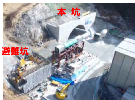
坑門部全景写真①
