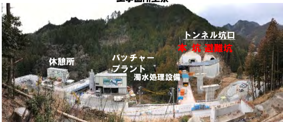
工事箇所全景
