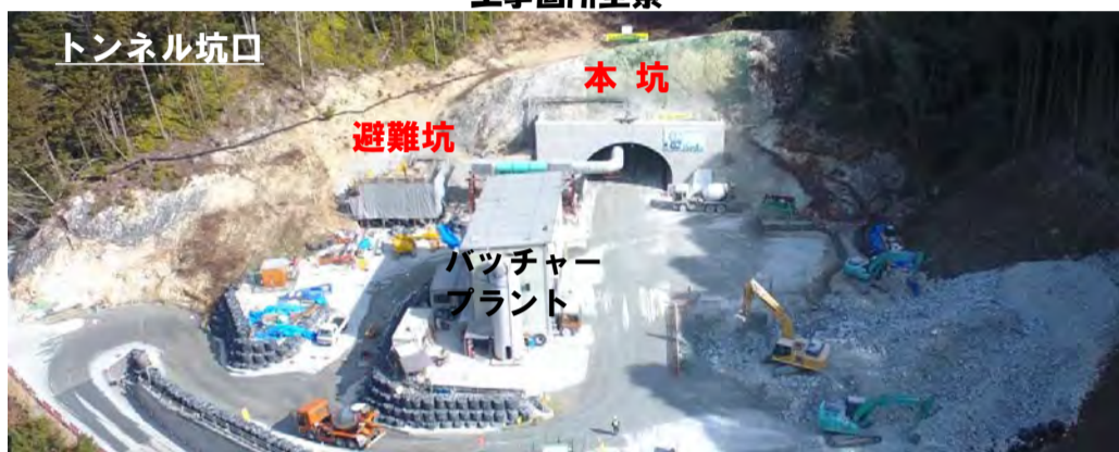
工事箇所全景
