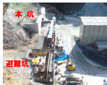
坑門部全景写真②
