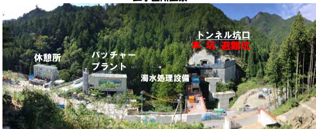
工事箇所全景
