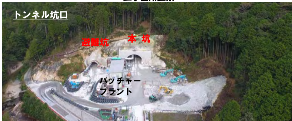
工事箇所全景
