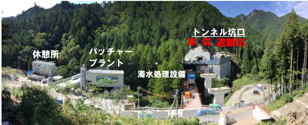
工事箇所全景
