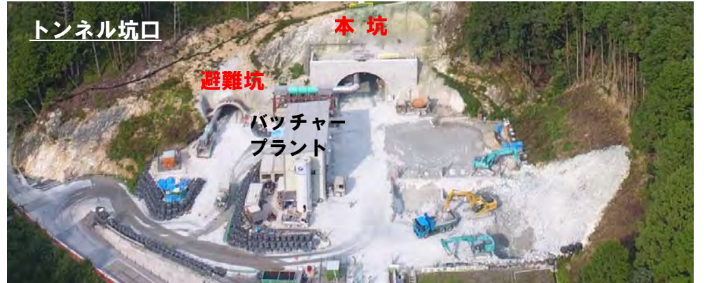
工事箇所全景
