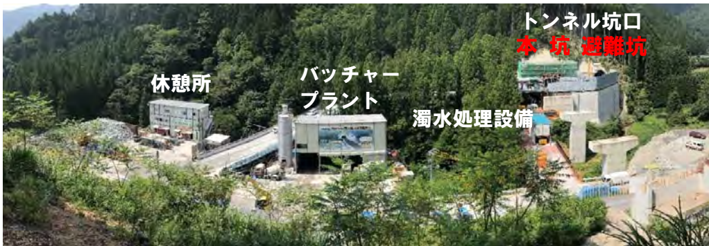
工事箇所全景
