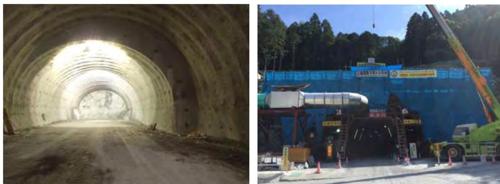
左の写真は、本坑の標準部と非常駐車帯部の全景写真になります。非常駐車帯部は、トンネル内走行中に非常事態等が起こった時に駐車するスペースになり、標準断面よりも広がっています。右の写真は、本坑の坑口全景になります。本坑の坑口周りを青いシートで囲っていますが、このシートの中には坑門工(入口部分の仕上げ)を実施するための足場が組立られており、コンクリートを打設するためにクレーンで荷を吊り上げ、型枠を組み立てています。
