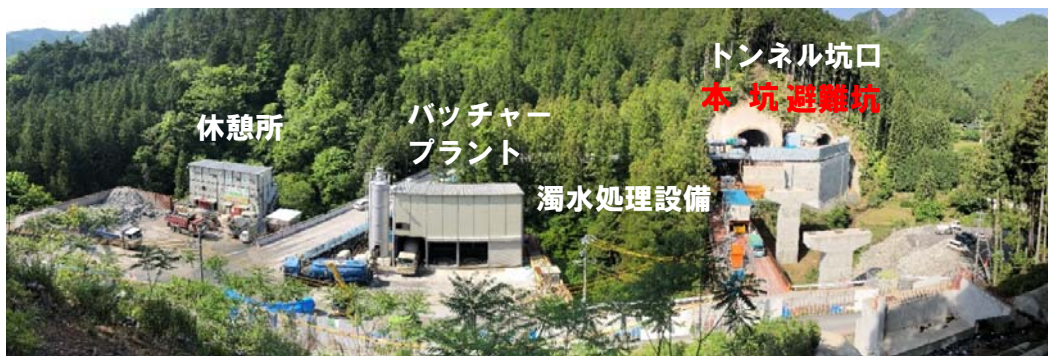
工事箇所全景
