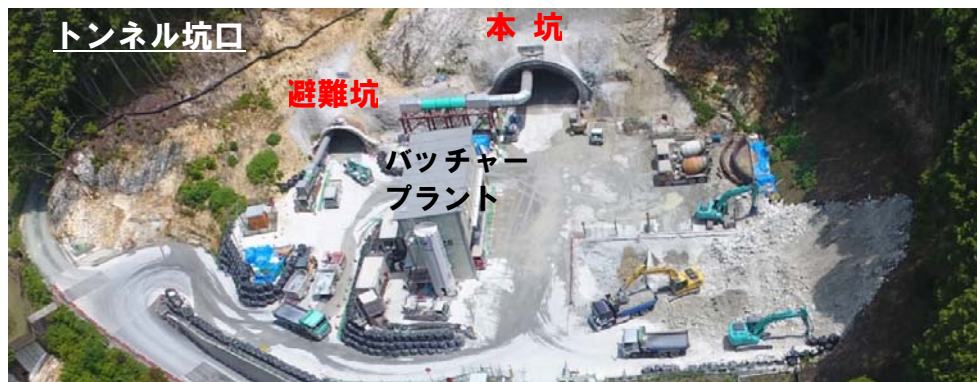
工事箇所全景
