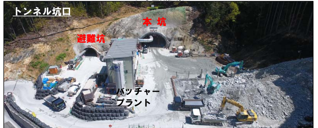
工事箇所全景
