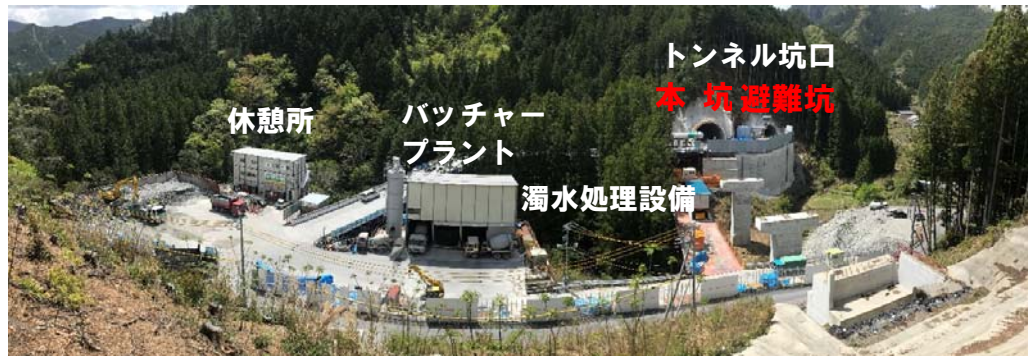
工事箇所全景
