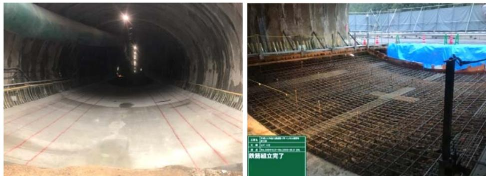
写真は、本坑入口部分の底板部分のコンクリートで、インバートコンクリートと言います。トンネルを円形状につないでトンネルの安全性を高めています(坑口部分は鉄筋造)。完成すると地中に埋まって見えなくなる部分ですが、見えないところにも安心して道路を通行できるように工夫がされています。
