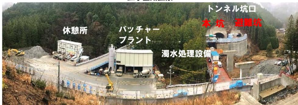
引続き、昼夜施工でトンネル工事を進めています。今月は、一時中断していた本坑の掘削作業を再開します。避難坑は引き続き掘削を進めていきます。また、仕上げの覆工(ふっこう)コンクリートの準備にも着手します。皆様のご意見を伺いながら進めてまいりますので、些細なことでもご相談ください。ご理解・ご協力のほどよろしくお願いいたします。
