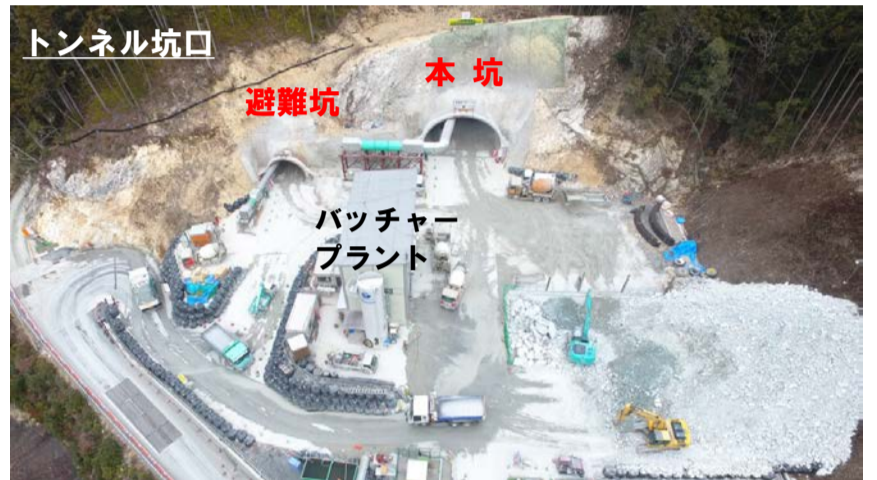
工事箇所全景
