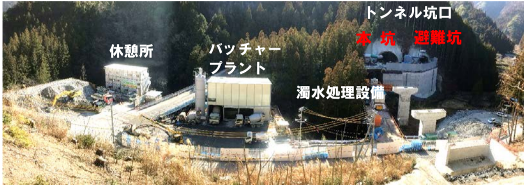
工事箇所全景
