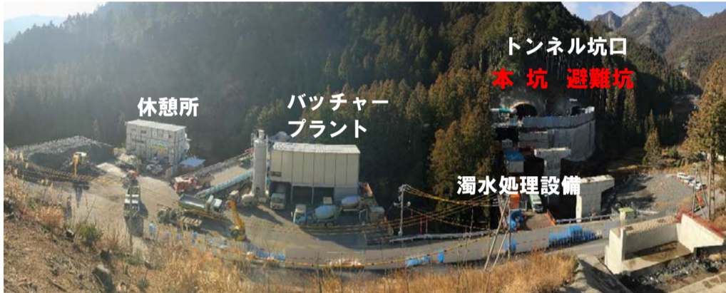
工事箇所全景
