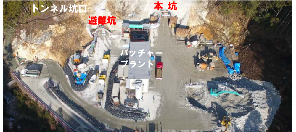
工事箇所全景
