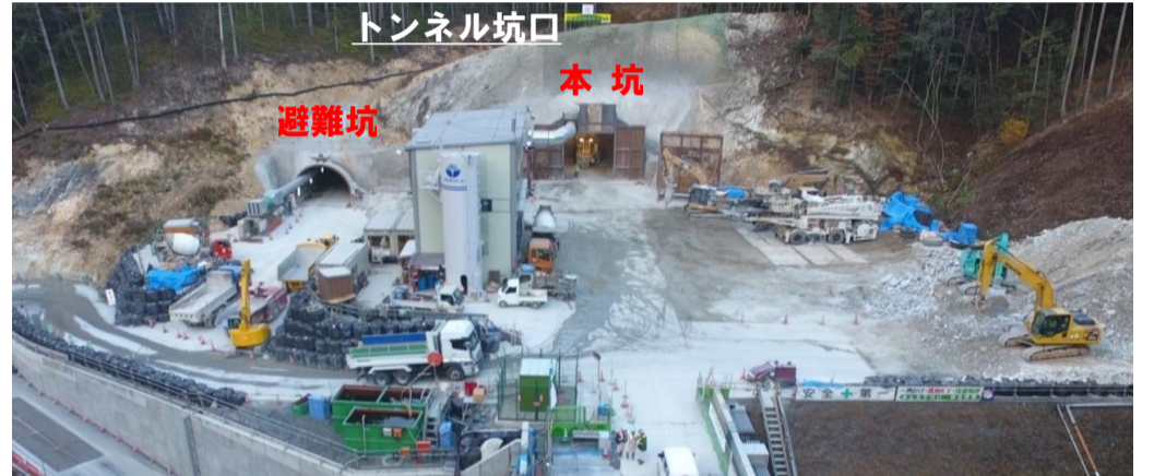
工事箇所全景
