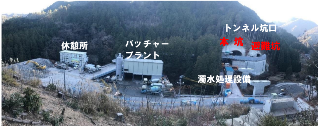
工事箇所全景
