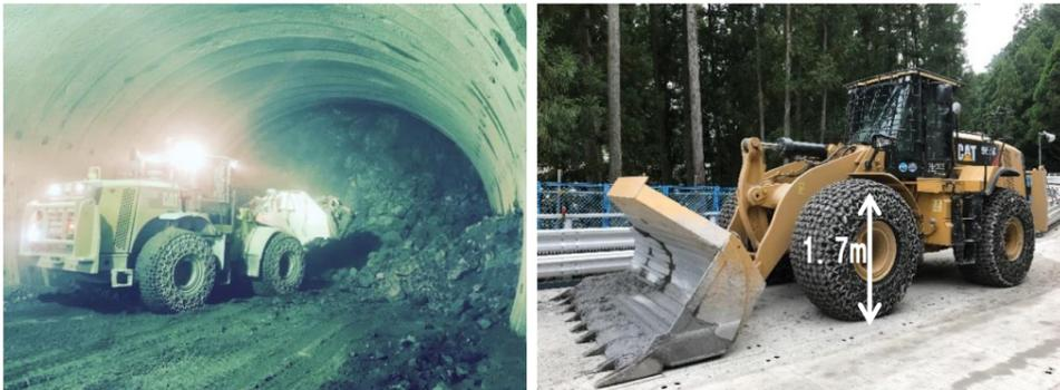
上の写真は、本坑のスリ(残土)搬出の様子です。ひとすくい3.5m<sup>3</sup>(約7t)の大きなバケットのホイールローダで重ダンプトラックに積み込みます。このホイールローダは大人の身長と同じほど大きなタイヤを履いています。
