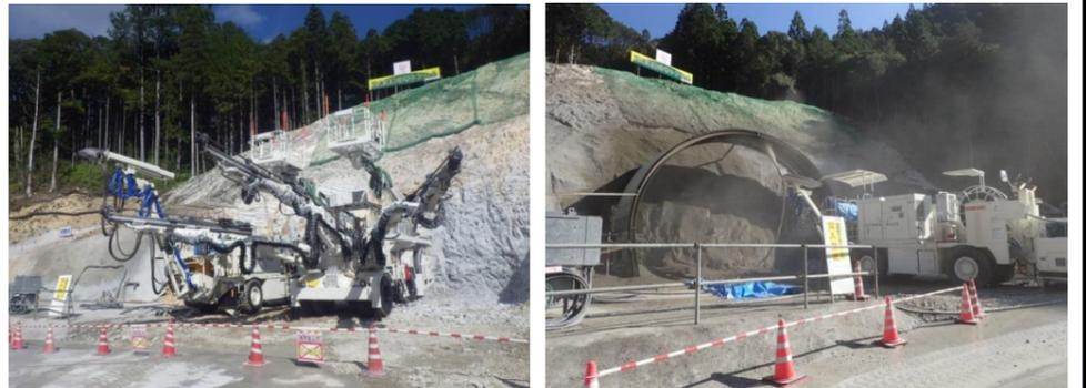
左上の写真は、本坑掘削用の機械になります。左からコンクリートを吹付ける吹付けロボット、火薬を詰める穴等を削孔するドリルジャンボになります。右上の写真は本坑の坑口付けを実施している状況で、吹付けロボットでコンクリートを吹付けています。
