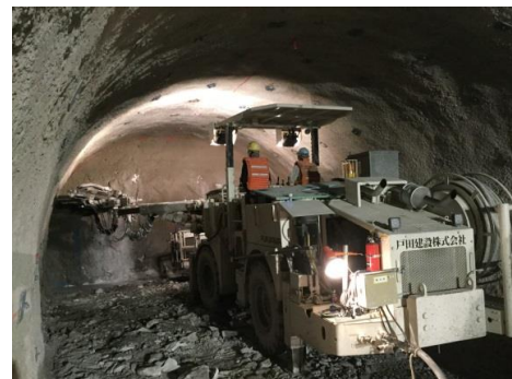
避難坑削孔状況(爆薬を詰める穴を削孔中)
