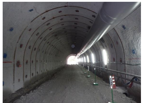
避難坑全景(坑内から坑口に向けて撮影)
