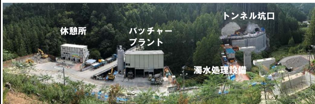
9月より、昼夜施工でトンネル工事を進めています。夜間の発破作業も開始しました。工事に伴う騒音は、防音扉や坑口周辺を防音シートで覆うなどの対策を行い極力騒音の低減を図っています。
