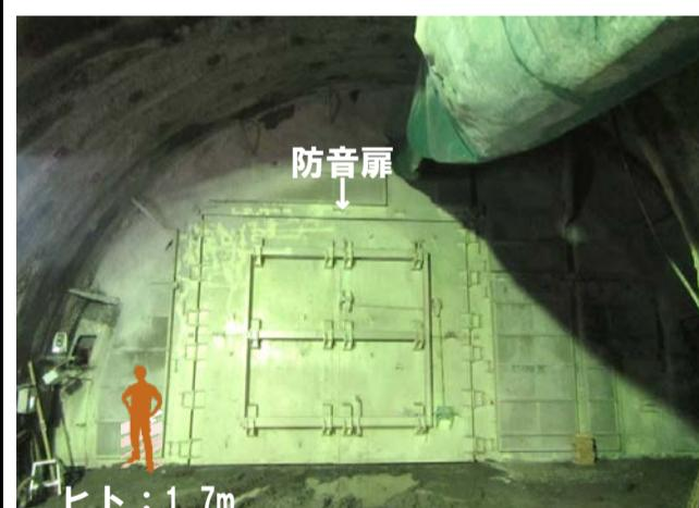
避難坑の中に防音扉を設置しました。充填したコンクリートの重さで発破の騒音を低減しています。
