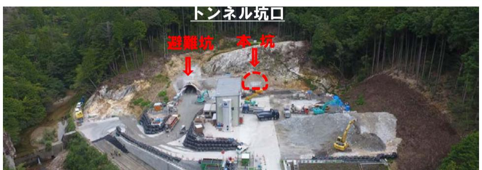
7月末から始まりました避難坑の掘削ですが、ようやく約150mほど完了しました。貴通に向けて引き続き昼夜体制で工事を進めていきます。また今月から本坑掘削に向けた準備を進めて、11月初旬頃から本坑掘削開始を予定しています。
