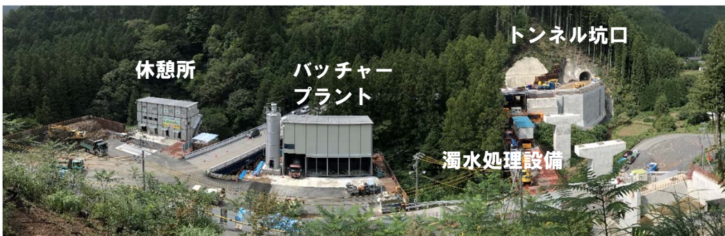
工事箇所全景(坑口対岸より望む)
