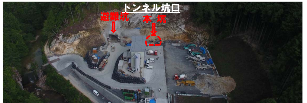
工事箇所全景(写真奥に向かってトンネルを掘削)
