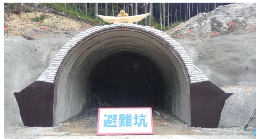
避難坑全景(写真奥に向かってトンネルを掘削)
