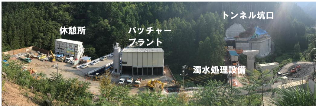
工事箇所全景(坑口対岸より望む)
