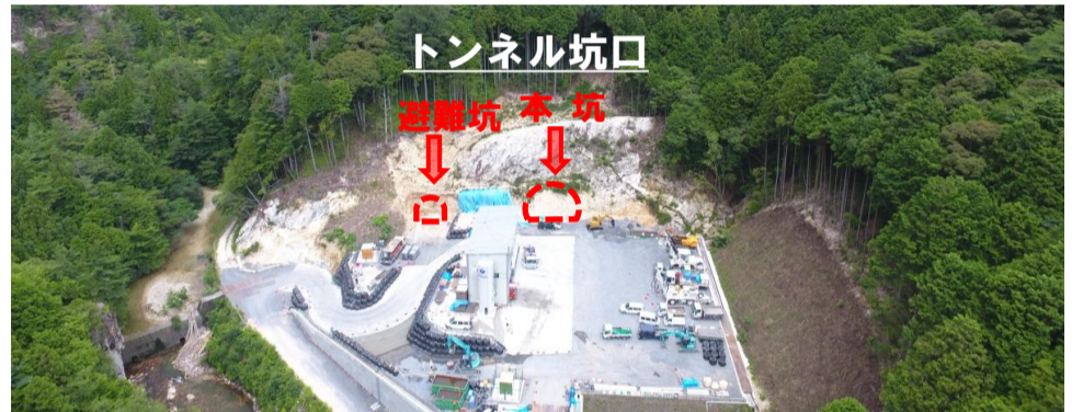
工事箇所全景(写真奥に向かってトンネルを掘削)
