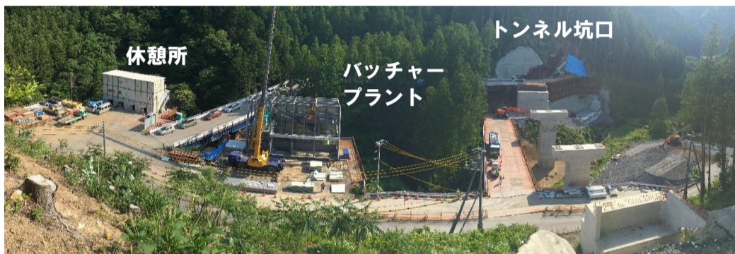
工事箇所全景(坑口対岸より望む)
