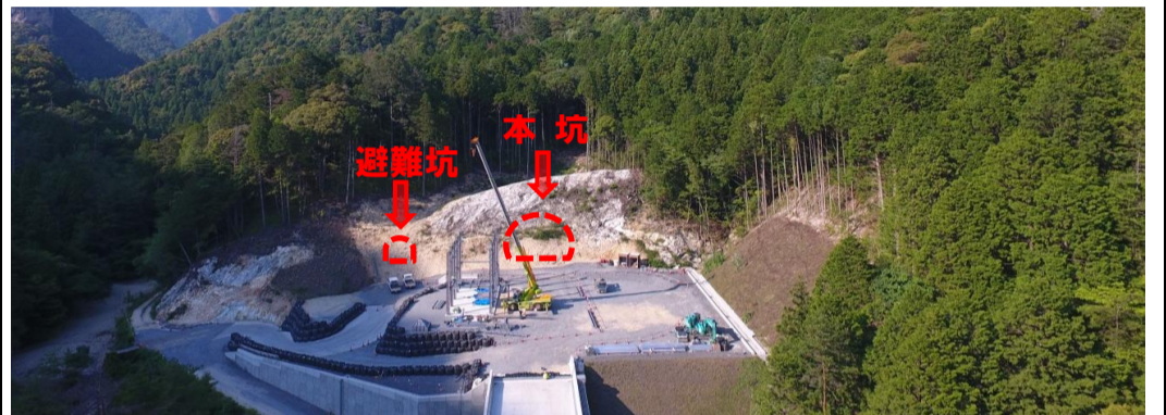
工事箇所全景(写真奥に向かってトンネルを掘削)
