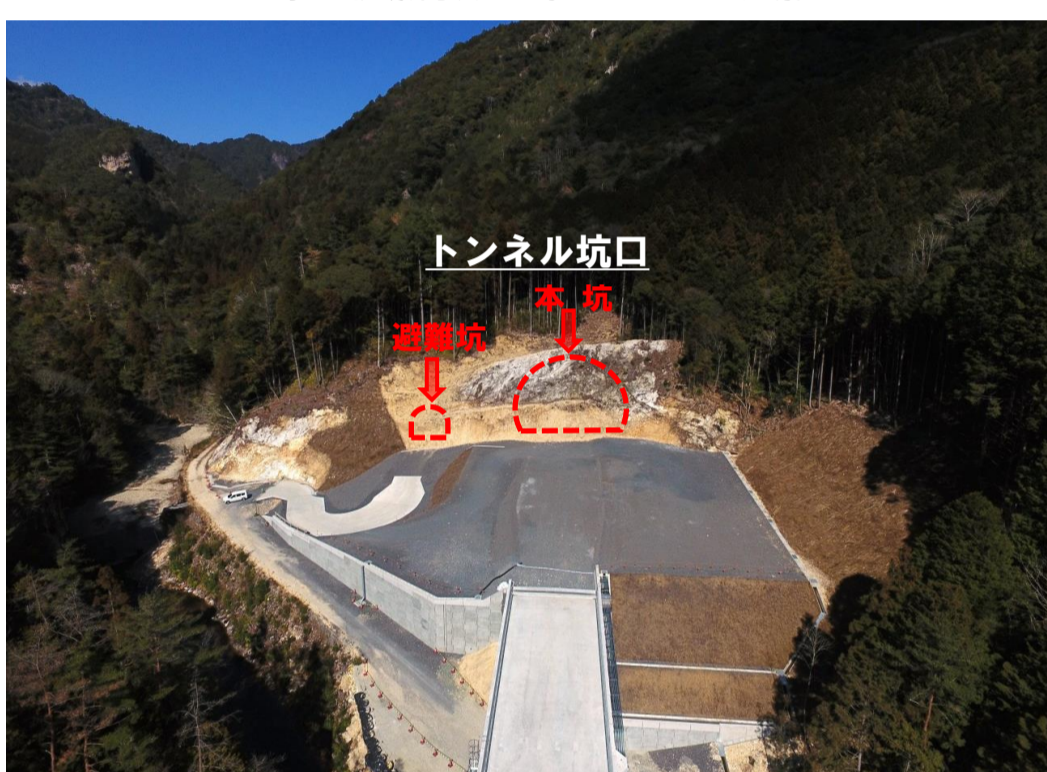
工事箇所全景(写真奥に向かってトンネルを掘削)
