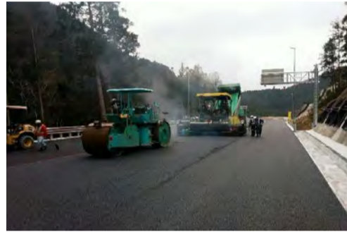
現場状況(表層の施工)
