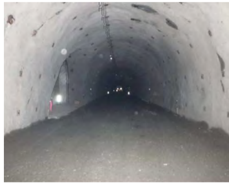
コンクリート舗装打設状況
